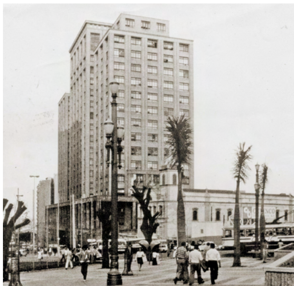
Prédio da Secretaria da Fazenda, onde a Prodesp iniciou as atividades
