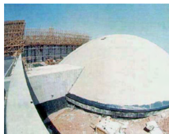
Construção da Sede em Taboão da Serra
